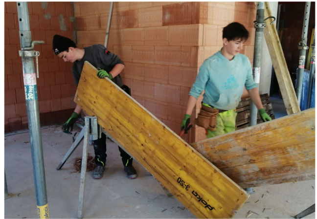
Leon Hager und Samuel Hager im Einsatz bei der Firma Hager Schalungsbau GmbH
