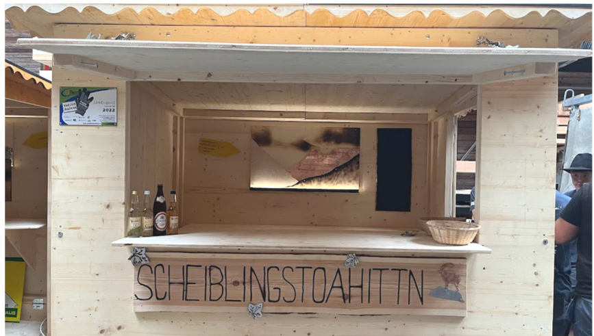
Die „Scheiblingstoahittn“ und 2 weitere wurden innerhalb von 42 Stunden errichtet!
