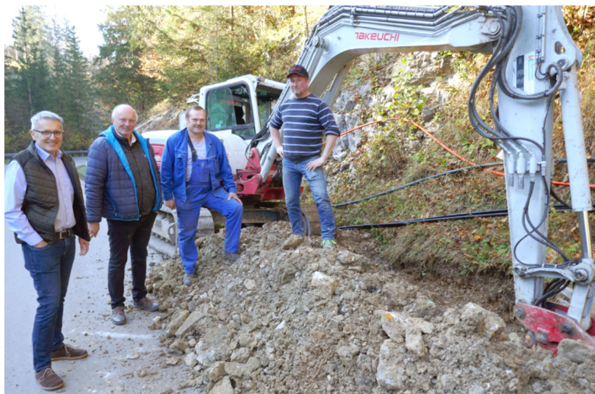
Bgm. Josef Schachner und Vzbgm. Johann Strohmayer überzeugten sich vom Baufortschritt und trafen dabei Johann Repper und Reinhard Halbartschlager.
